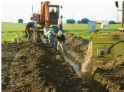
写真1 暗きよ敷設による排水性の改善
