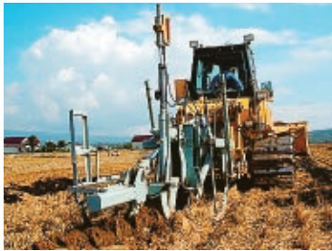
写真1 無材暗渠(カッティングドレン工法)の施工
