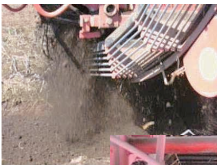
ロータリーバケット下部からの土砂排出状況
