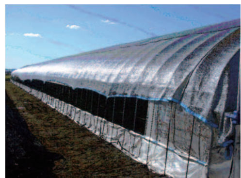
写真2 遮熱資材の使用
