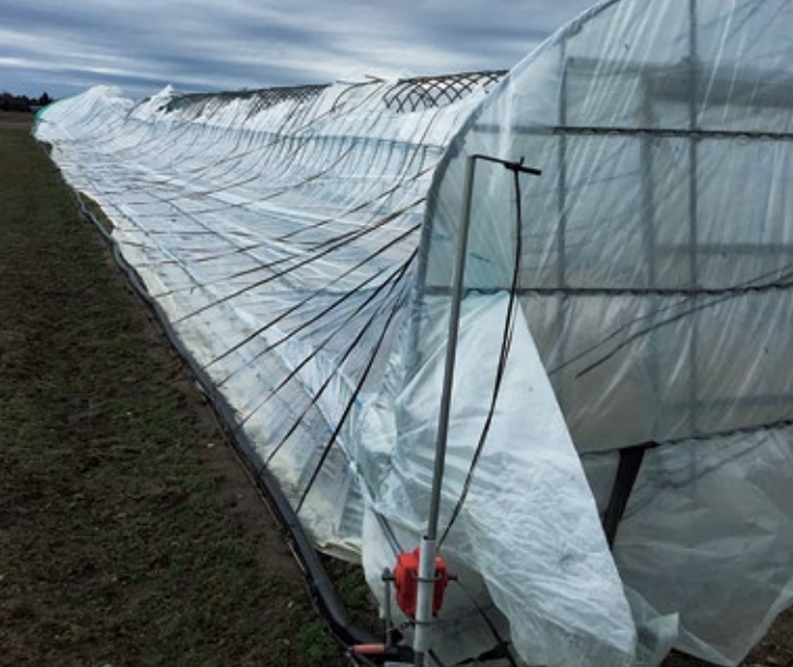
写真1. 台風で倒壊したビニールハウス
