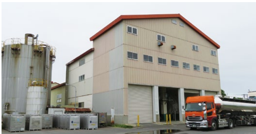
写真2. 王子コーンスターチ株式会社北海道工場（砂川市）
