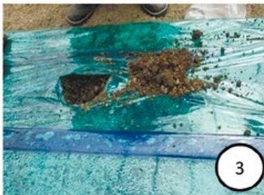
ビニールの切り残りを内側に折って土を掘る
