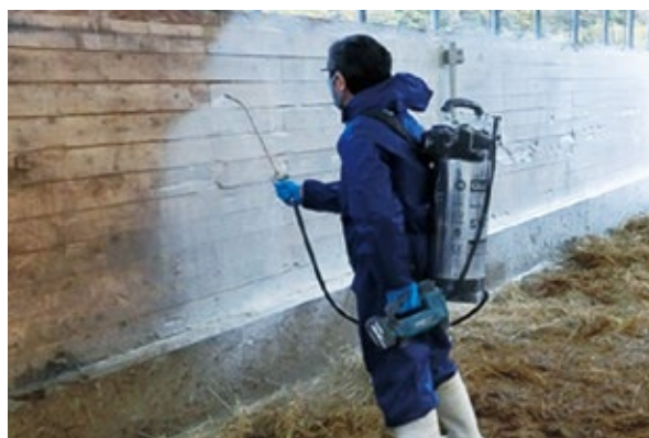
写真1. 蓄圧式石灰乳塗布機での施工風景
