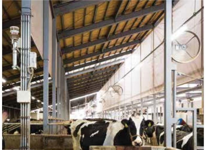
パナソニックが開発した自動換気システム。気象庁で使っているのと同様の高精度なセンサーで温度と湿度を感知して、牛舎内の空気を入れ換えます。夏は天井に吊り下げられたカーテンに風を当て、牛の頭に風速2mの風を落とすことで体感温度を下げ、暑熱ストレスを軽減します。
