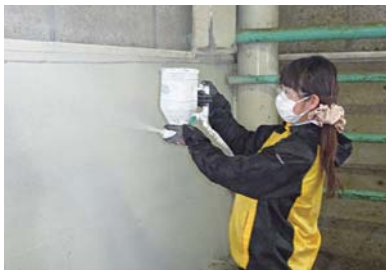
万能ガンを使って塗布する様子
