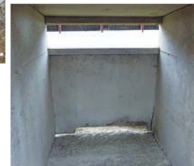
塗布後の子牛ハッチ内部
