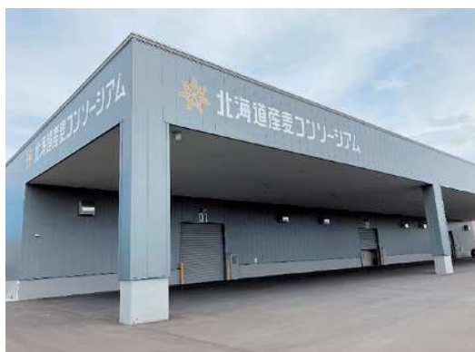
北海道産麦専用倉庫（石狩市）
