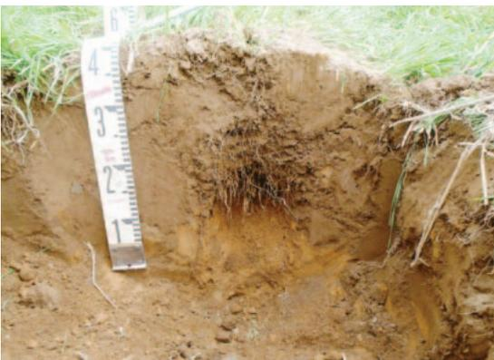
写真4 心土破碎の施工状況(弾丸暗きよ)
