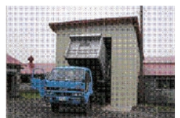
写真5 農家のTMR受け入れ施設
