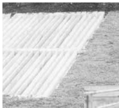
写真2. 水槽前に設置中の木製すのこ
