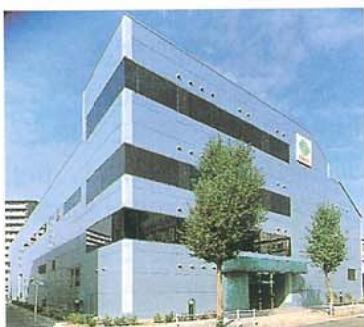
写真1 カネハツ食品(株) 第一工場
