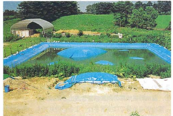
約1年経過した雨水分離シート設置ラグーンの状態
