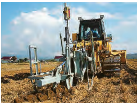
カッティングドレーン工法の施工
