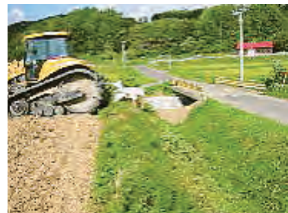
サブソイラの施工
