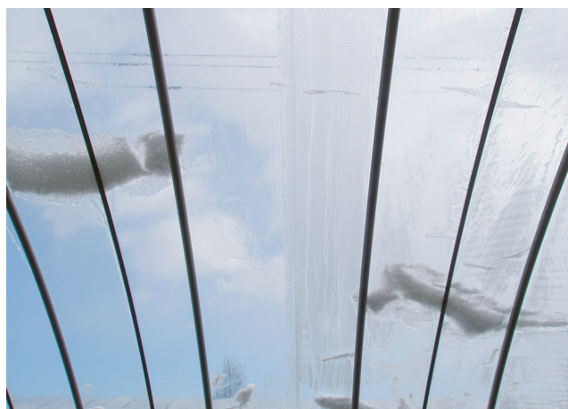
新型クリントート ← | → 従来のクリントート
