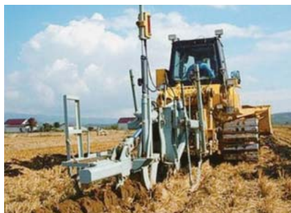
無材暗きょの施工
