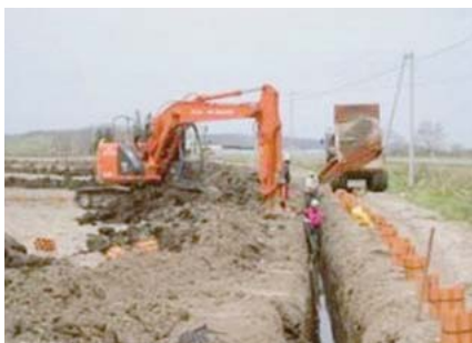
明きょ・暗きょの施工
