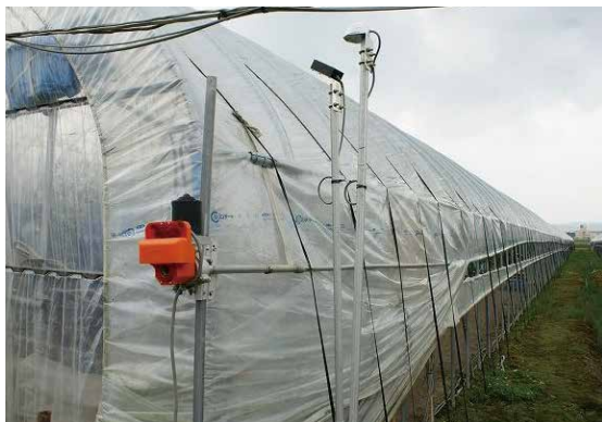
[写真3] 自動換気装置（天候感知センサー付き）
