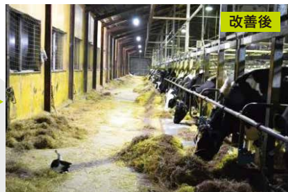
＜牛舎の照明を改善＞ 飼槽通路上にある照明を蛍光灯からLED蛍光管に交換。照度がろうそく程度の19ルクスから街灯並みの50ルクスへと上がり、足元が見やすく作業もしやすくなった。
