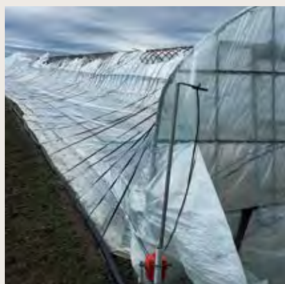
台風で倒壊したビニールハウス
