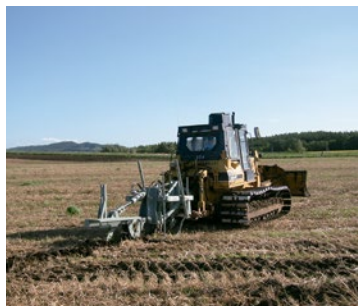
写真2. カッティングドレーンによる排水対策
