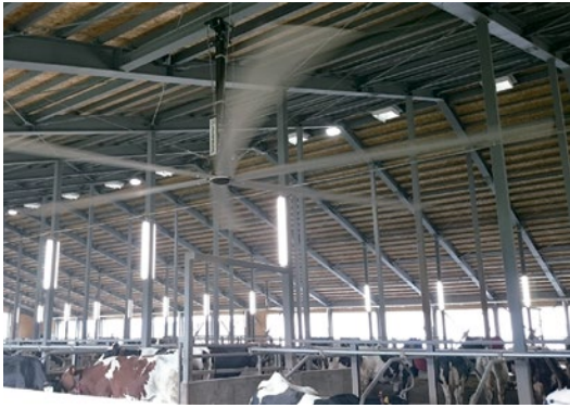
写真1. 大型のシーリングファンを取り付けた牛舎 体感温度を下げて暑熱ストレスを緩和します。
