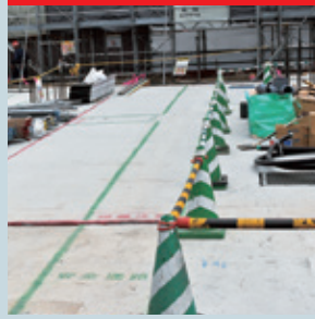
作業導線の確保
