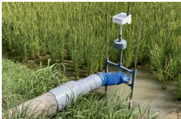
写真 2. 給水口とゲートの高さを調整した事例（調整後）
