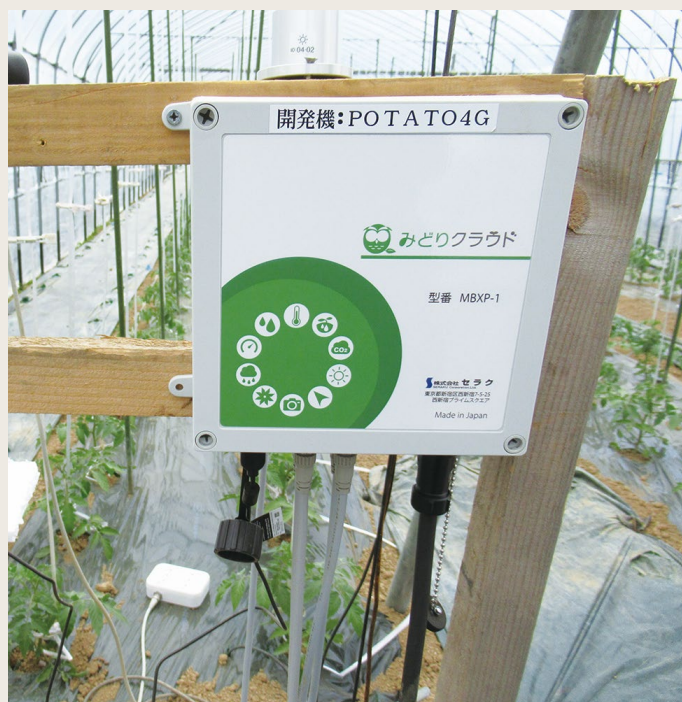
写真1. 機器設置状況 (5月)
