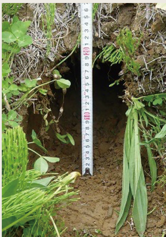
写真3. カットドレーン施工による溝
