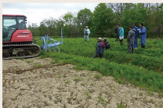
写真1. カットドレーン施工の様子①
