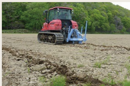
写真2. カットドレーン施工の様子②
