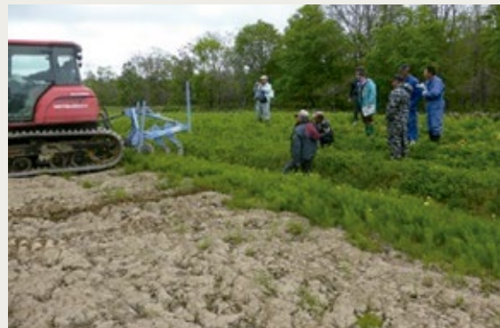
写真1. カットドレーン施工の様子①
