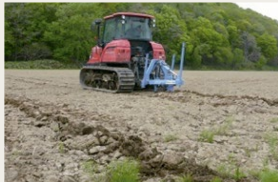
写真2. カットドレーン施工の様子②
