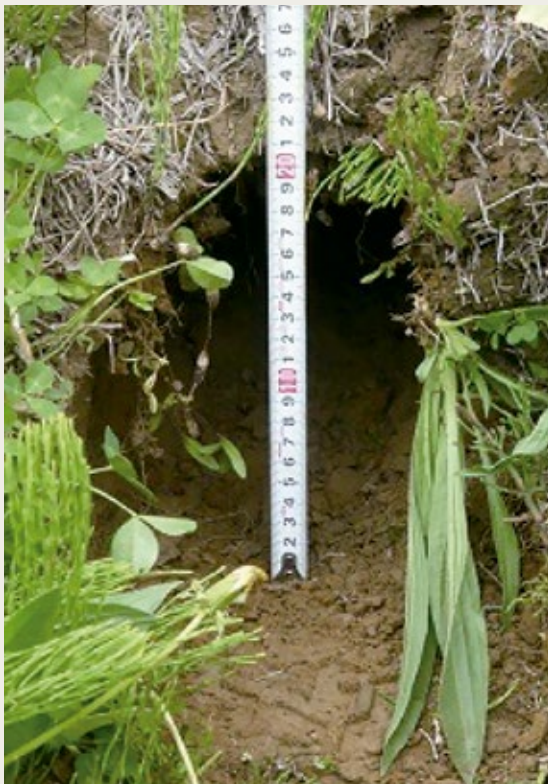
写真3. カットドレーン施工による溝
