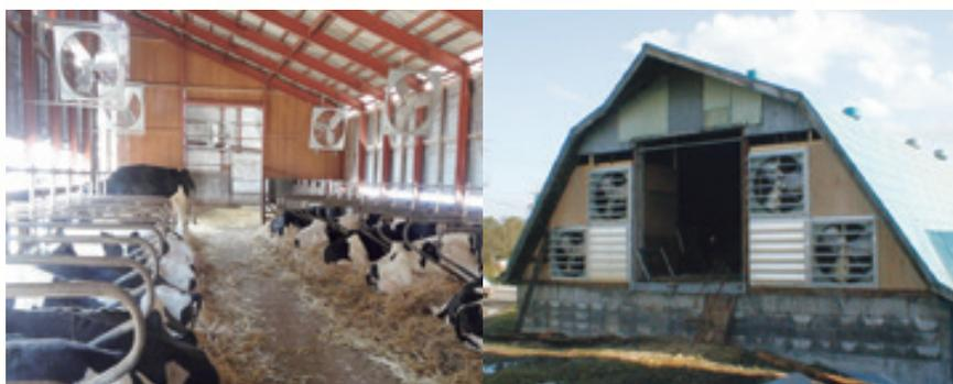
写真9. 牛舎内部ファン（左）、トンネル換気（右）
