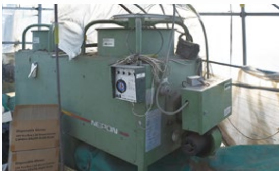
写真3. 変温管理に不可欠な4段サーモの暖房機。日の出の時間にあわせて1時間に2℃ずつ温度を上げていきます。
