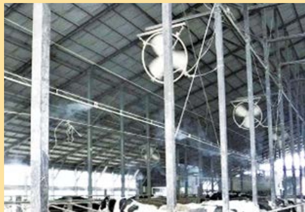
写真1. ミスト機を利用した細霧冷房と送風機を導入した牛舎。
