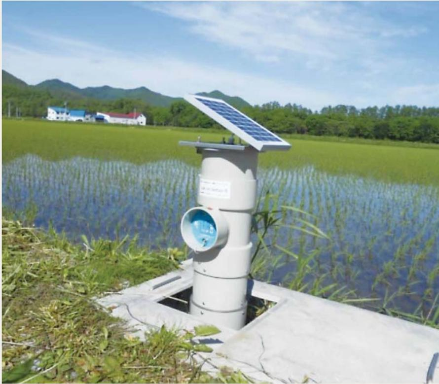
制御装置を取り付けた給水バルブ
